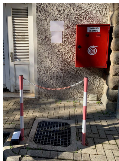
Foto 14: Vista del pozzetto contenente l'attacco dell'idrante sottosuolo e relativo “corredo” in facciata
