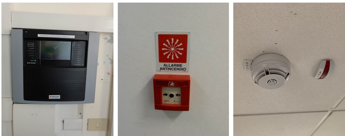
Foto 9: Vista della centralina e dei dispositivi a servizio dell'impianto antincendio
