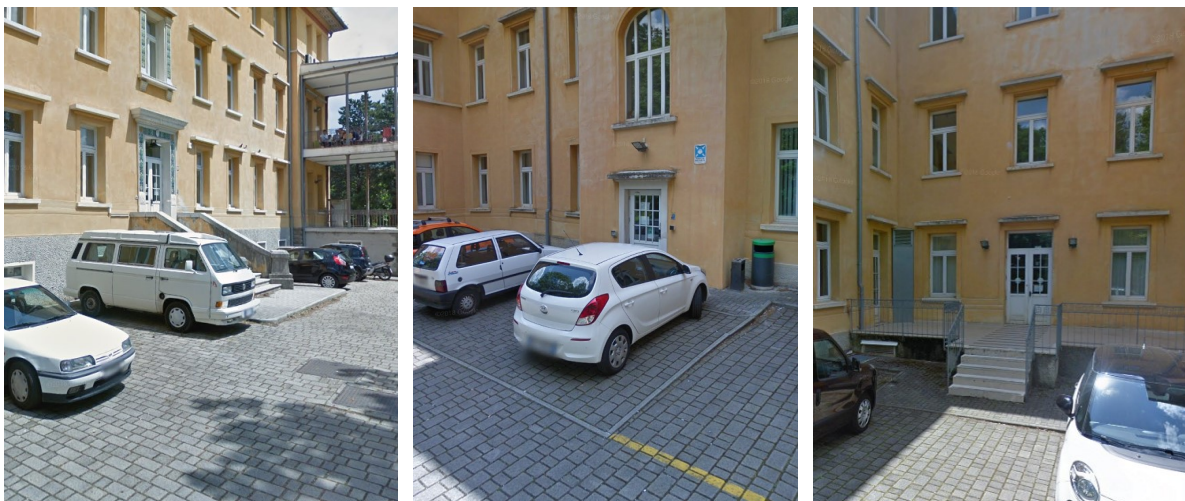
Foto 7: Vista delle uscite di emergenza al piano rialzato
