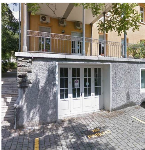
Foto 5: Vista frontale della Palazzina Q dall'uscita di emergenza presente al piano seminterrato zona deposito
