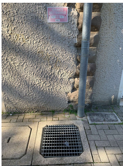
Foto 14: Vista del pozzetto contenente l'attacco dell'idrante sottosuolo e relativo “corredo” in facciata
