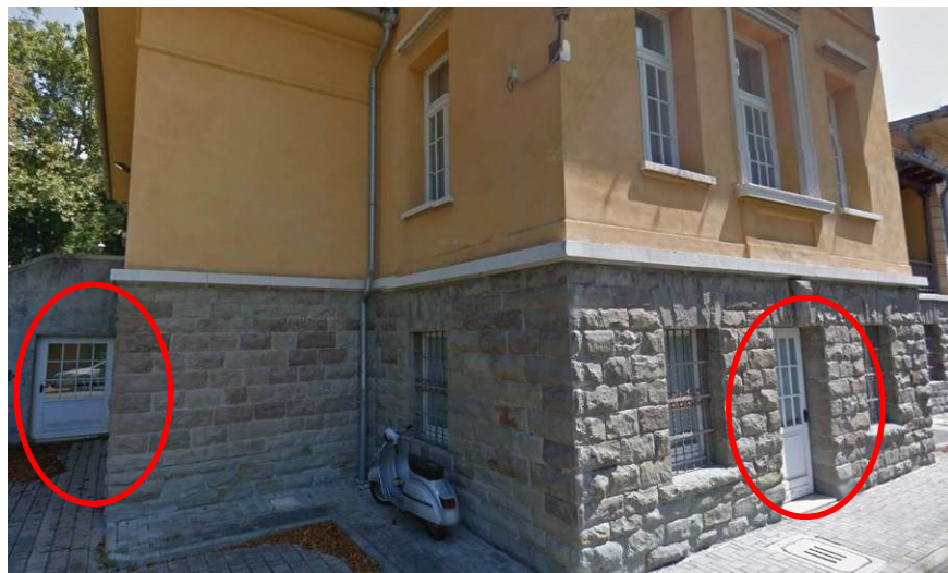
Foto 6: Vista di due delle sette uscite di emergenza presenti al piano seminterrato
