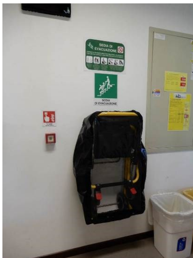
Foto 17: Vista della sedia per l'evacuazione in condizioni di emergenza ubicata al piano rialzato
