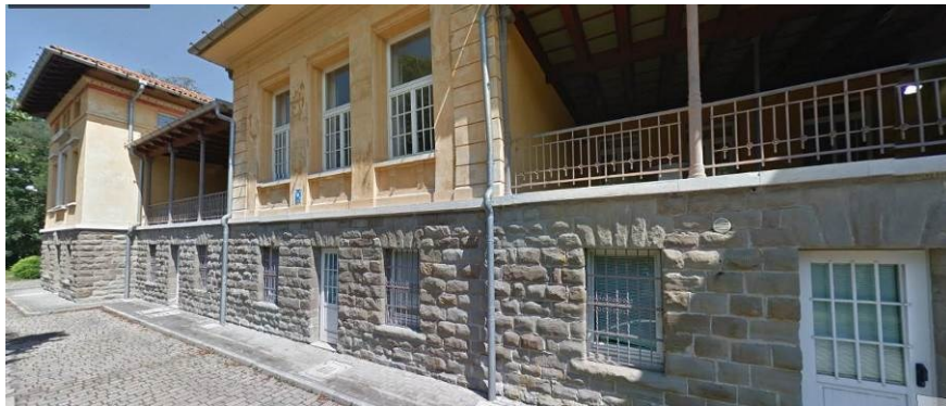
Foto 5: Vista dell'edificio dalle due terrazze
