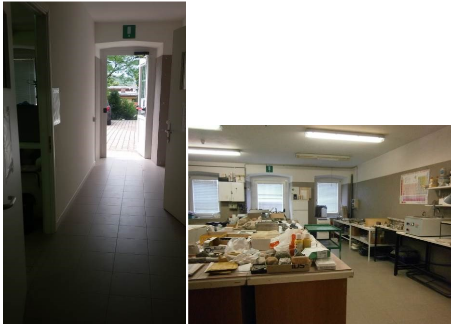
Foto 21: Vista delle uscite di emergenza al piano seminterrato nelle Stanze 025 (a sinistra) e 029 (a destra)
