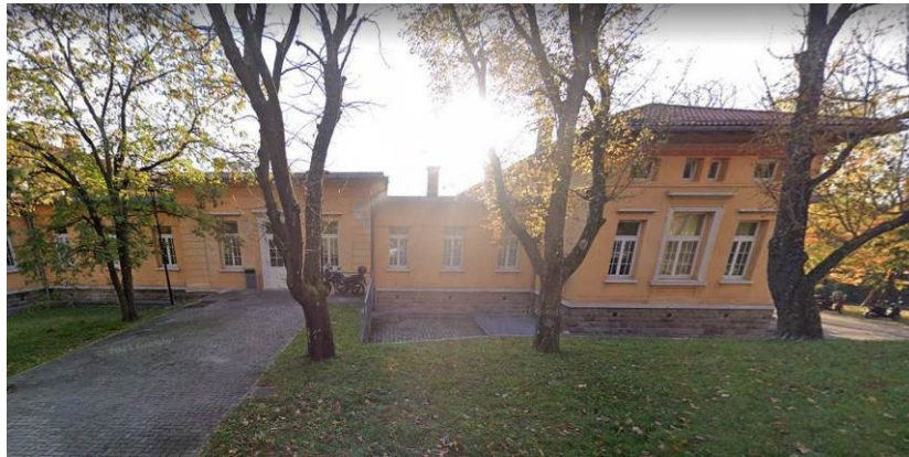
Foto 4: Vista dell'edificio dal retro (lato piazzale Canestrini)
