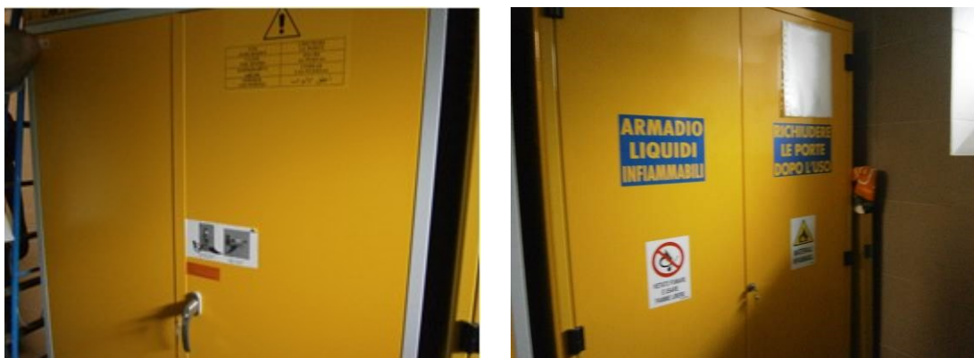
Foto 15: Vista degli armadi di sicurezza per gli agenti chimici pericolosi presenti nella stanza 004 al piano seminterrato
