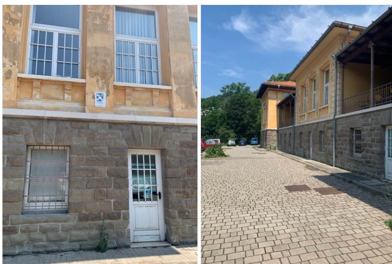
Foto 9: Vista del "Punto di raccolta" per la palazzina N sito nel parcheggio antistante il lato dell'edificio ove sono ubicate le due terrazze
