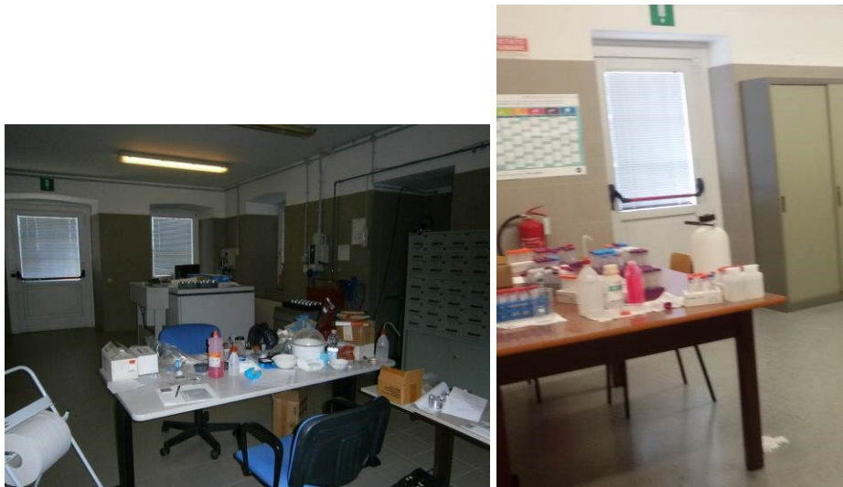
Foto 20: Vista delle uscite di emergenza al piano seminterrato nelle Stanze 021 (a sinistra) e 023 (a destra)
