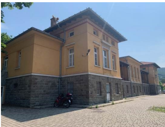
Foto 1: Vista dell'edificio Palazzina N dall'esterno
