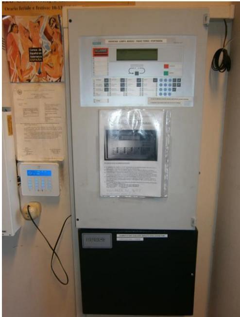
Le segnalazioni d'allarme/guasto (ingessi di centrale) giungono da rivelatori ottici di fumo, di tipo indirizzabile, posti a soffitto e nei controsoffitti o da pulsanti d'allarme ad attivazione manuale (pulsanti a rottura) collocati in corrispondenza delle vie d'esodo. Ogni anomalia viene elaborata dalla centrale che, a seconda si tratti di guasto o allarme incendio, attua una delle seguenti procedure standardizzate:
