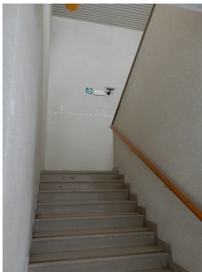
Foto 13: Vista della scala principale di collegamento dei piani interni
