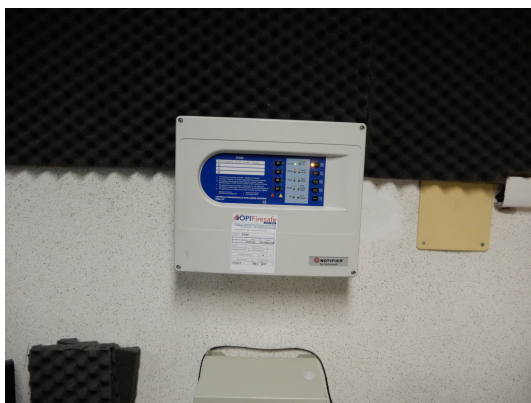
Foto 17: Vista Centralina di rilevazione incendi posta al piano terra e particolare dell'allarme sonoro antincendio posizionata ai vari piani dell'edificio.
