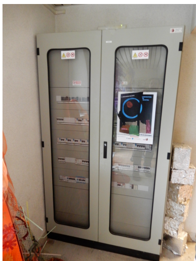
Foto 18: Vista del quadro elettrico generale posto al piano terra e vista di pulsanti di sgancio elettrico generale posti nelle aree comuni o di passaggio al primo e secondo piano.
