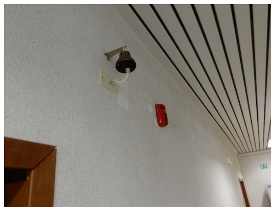
Foto 17: Vista Centralina di rilevazione incendi posta al piano terra e particolare dell'allarme sonoro antincendio posizionata ai vari piani dell'edificio.
