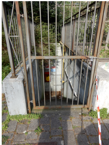
Foto 5: Vista scala di accesso alla centrale termica al piano interrato
