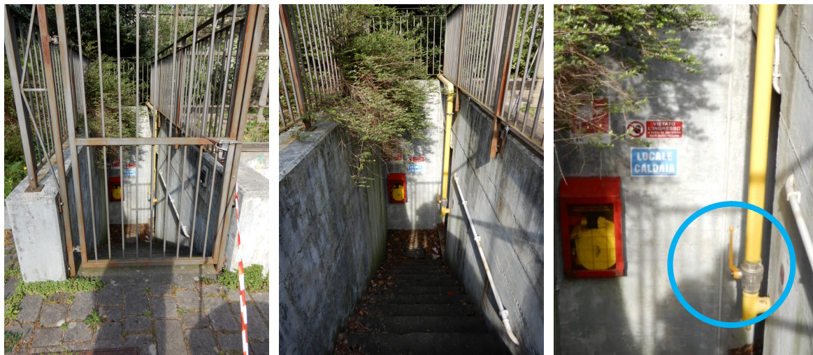
Foto 19: Vista dell'accesso al Locale Caldaia posta al piano interrato.
