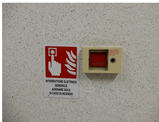
Foto 18: Vista del quadro elettrico generale posto al piano terra e vista di pulsanti di sgancio elettrico generale posti nelle aree comuni o di passaggio al primo e secondo piano.
